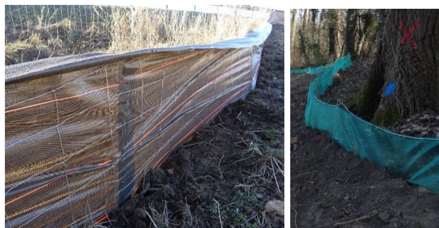
Exemples de barrières amphibien : bâche et filet, et de clôture agricole (Eco-Stratégie)
